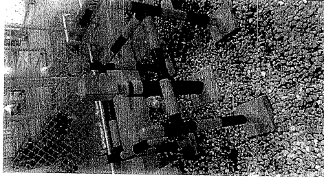
ภาพแท่งขั้วแอโนดฝังใต้ดิน(ของ ปตท.) รวมทั้ง CP Test Post สำหรับใช้การทางานของระบบ CP
